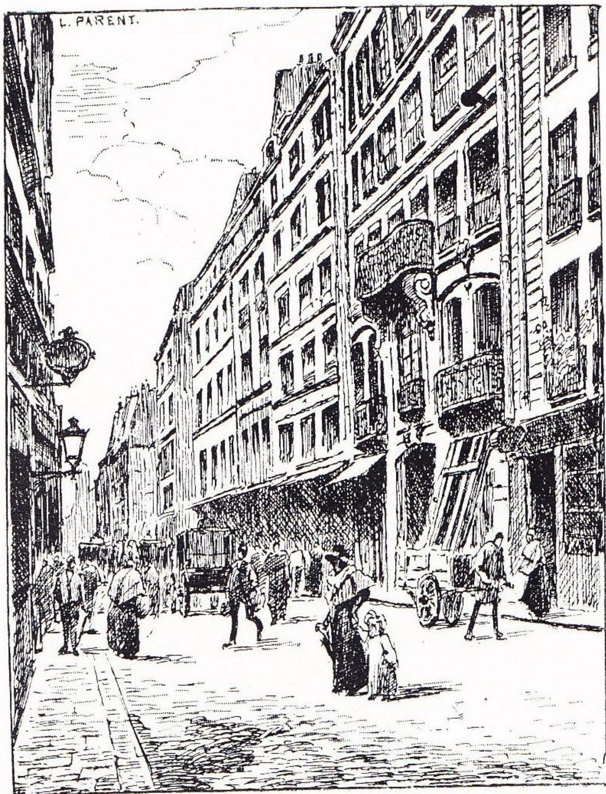
LA RUE DU PETIT-PONT (MAISON N° 10).
